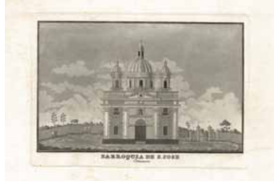
Frente de la Iglesia de San José en Extramuros. 1800 Instituto Cartográfico de Cataluña
